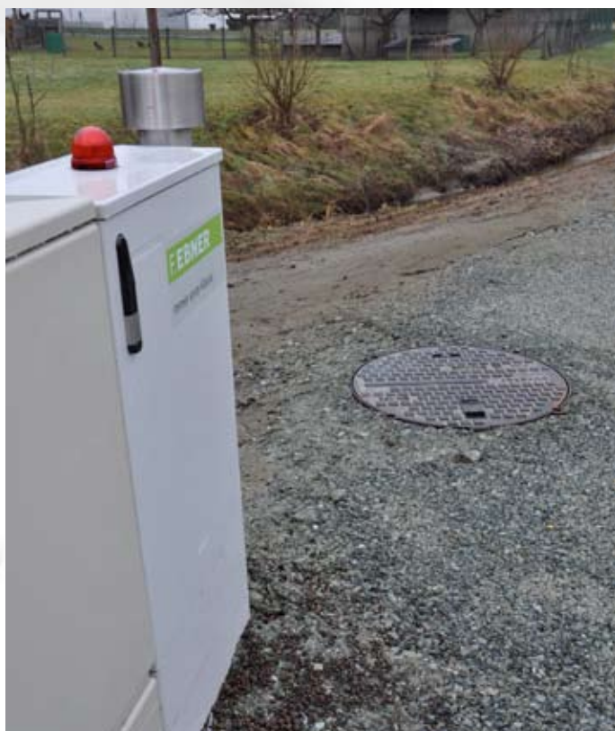
Freiluftsäule mit ROM-Control Steuerung
